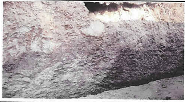
Foto1: Sanjeado para muro de contención
