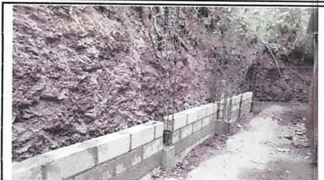
Foto 2: Cimentación del muro de contención
