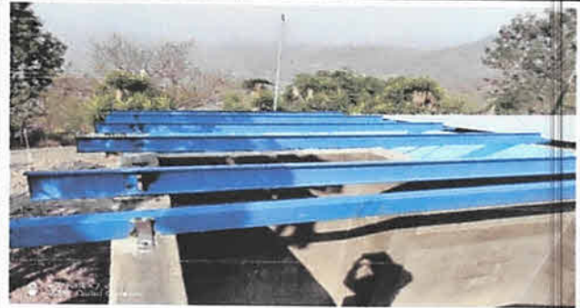
Foto 4: Restauración del techo dañado
