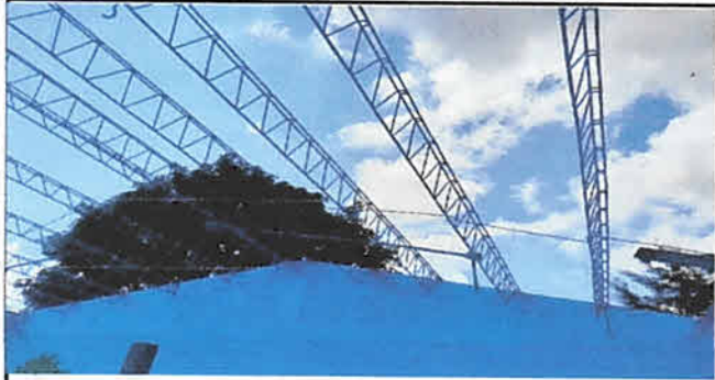
Foto1: Restauración del Techo dañado.
