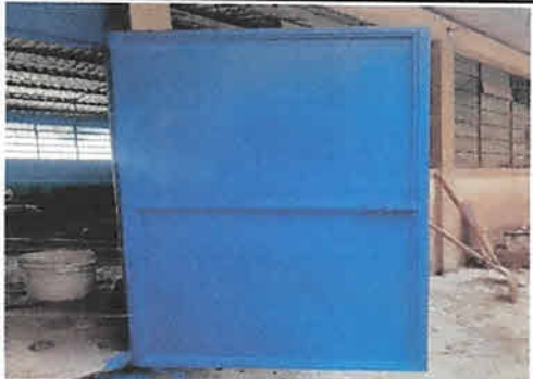
Foto 3: Mejoramiento de puertas lijado y pintado.
