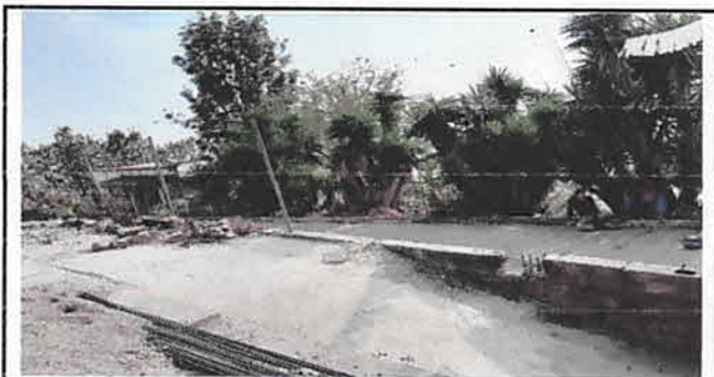
Foto 5: Desinstalación de malla dañada
