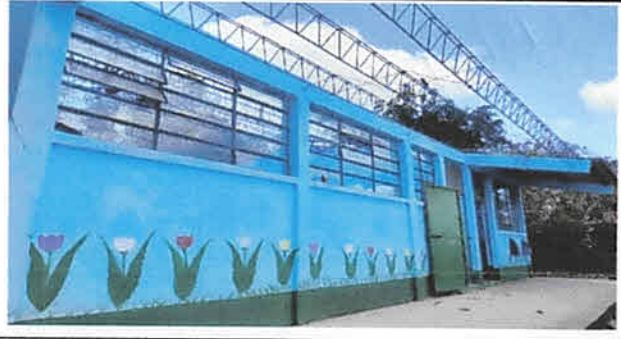
Foto 5: Restauración del techo dañado
