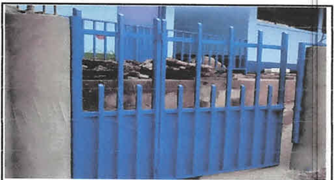
Foto 4: Instalación de puerta principal
