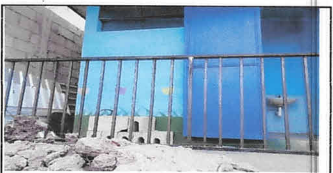
Foto 6: Fabricación e instalación de Baranda
