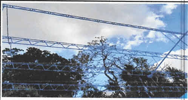
Foto 6: Restauración de techo dañado
